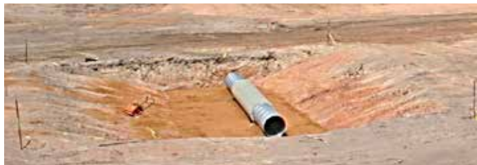
Rys. 1. High Strength Culvert – wzmocnienie wraz ze stalową rurą tworzącą przepust Źródło: Za zgodą Theater Lead FSR, Asymmetric Technologies Mr. Steve Cramer
