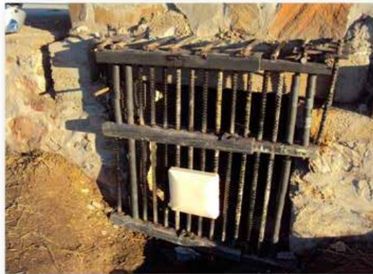
Rys. 8. SENSOR – przykład zamontowania na TYPE I CULVERT DENIAL DEVICE
